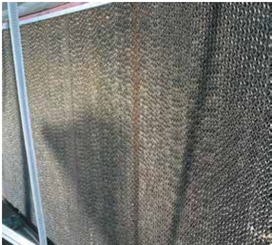
Hình 11. Tấm làm mát (trái), quạt hút (phải) lắp đặt ở chuồng kín nuôi vịt, ngan
