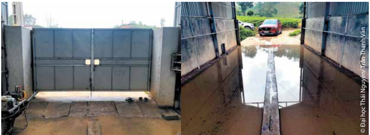
Hình 35. Hệ thống khử trùng ở cổng trại
